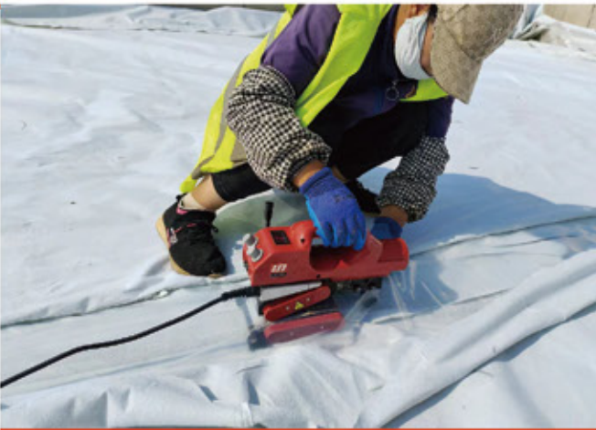
两布一膜复合膜焊接 LST8000D
