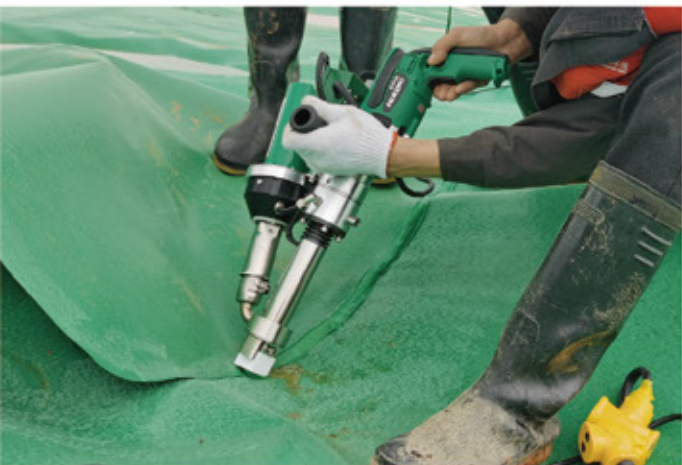
土工膜的修补焊接 LST600A
