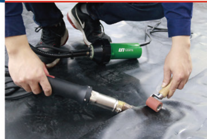
土工膜的修补焊接 LST2000
