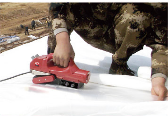
复合土工膜材料焊接 LST800
