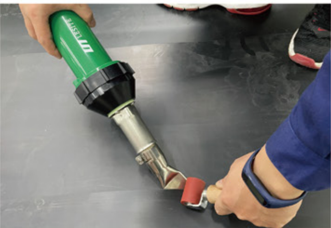
土工膜的修补焊接 LST1600A
