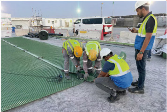
HDPE(2.5mm) 隧道排水板焊接 LST900
